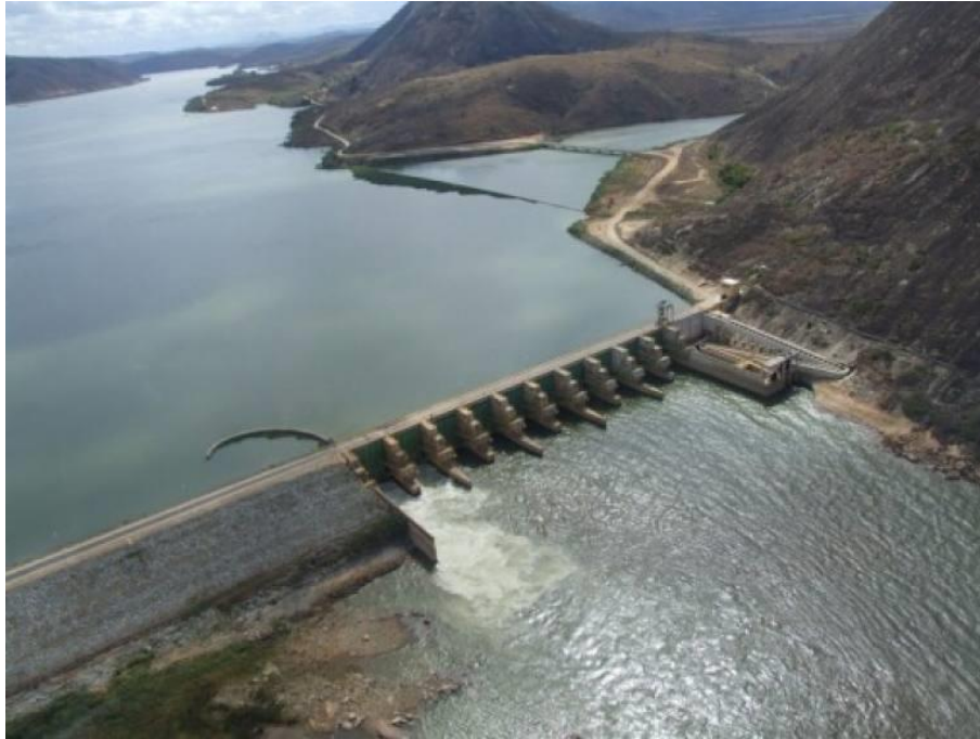
Figura 1 – Reservatório da Usina Hidrelétrica Eliezer Batista (UHE AIMORÉS, 2015).
